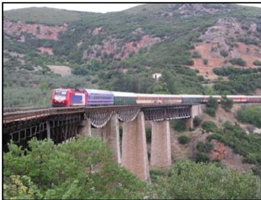
Σχήμα 13. Γέφυρα του Γοργοποτάμου κατά τη διάρκεια διέλευσης σιδηροδρομικών συρμών. Οι ταλαντώσεις που εκτελεί η γέφυρα κατά τη διέλευση των συρμών ,μετρώνται με όργανα RTS και GPS
